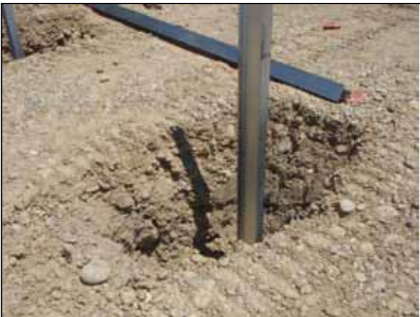
Figure 20 : Types de fondation - pieux battus (Source : Guide MEDDTL 2011 – NCA, 2015)
