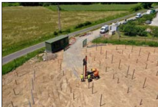
Figure 27 : Illustration de la pose des structures porteuses (Source : Soleil Du Midi Développeur)
