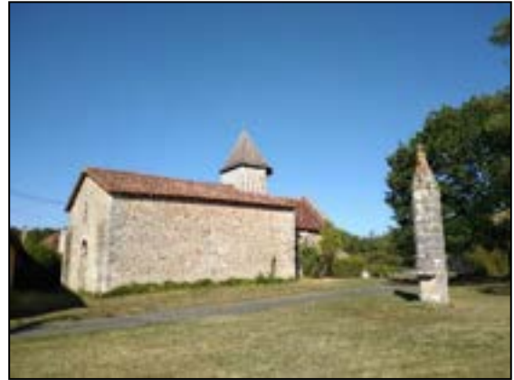
Figure 34 : Site de Lenest à Saulgé, (Source : NCA environnement, 2020)
