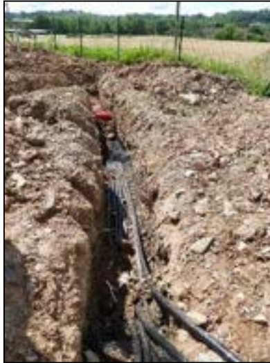
Figure 26 : Illustration d'une tranchée pour le passage des câbles (Source : Soleil Du Midi Développement)
