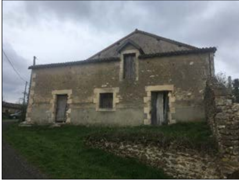
Figure 202 : Photographie de la bergerie dans son état actuel (Crédit photo : Soleil du Midi Développement)
