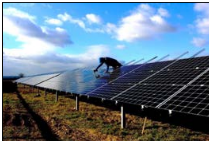
Figure 18 : Exemple de mise en place de modules (Crédit photo : Soleil Du Midi Développement)
